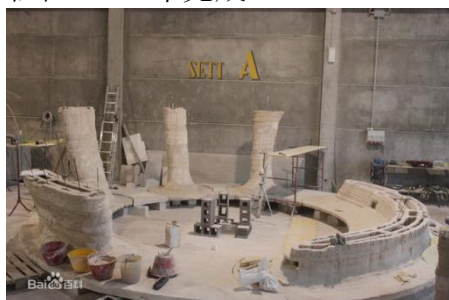
3D 打印混凝土建筑框架
